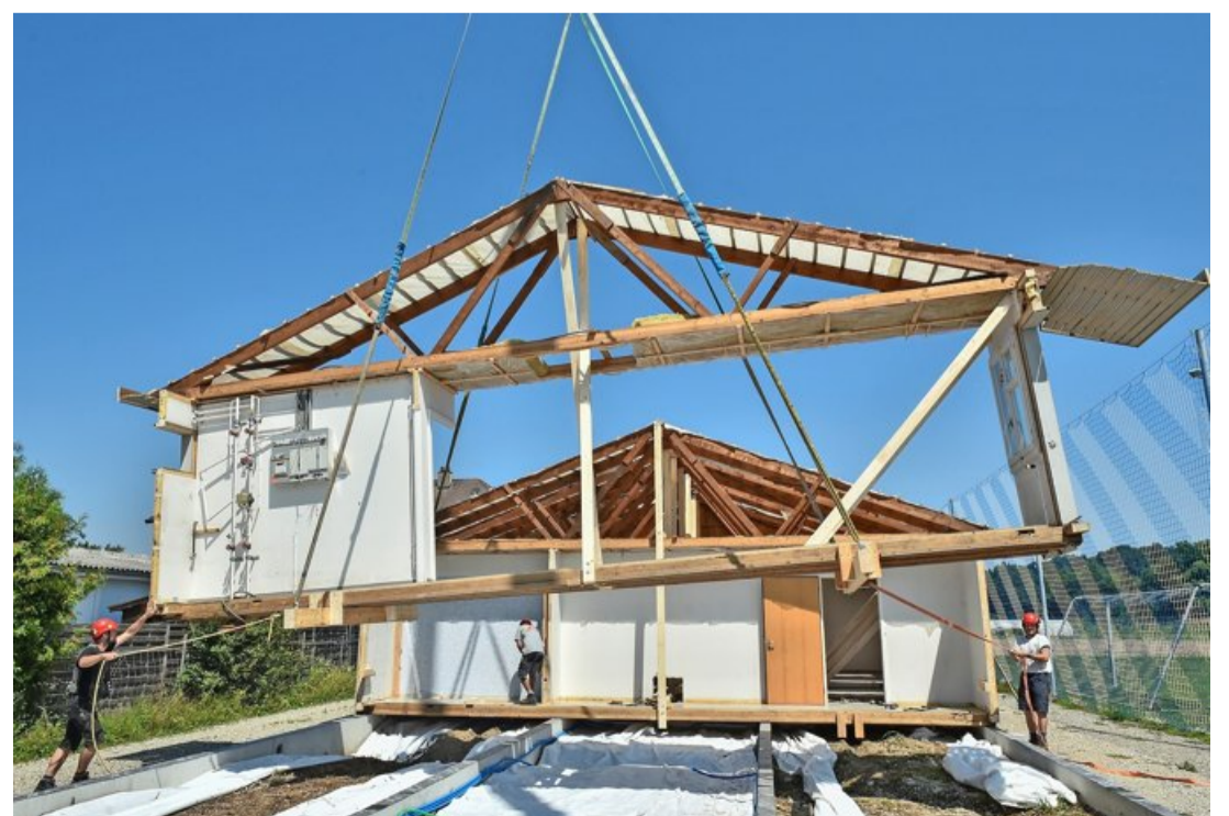
Massarbeit ist gefragt: Auf dem Sportplatz werden die Elemente wieder zusammengesetzt.
